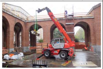
IL PESO DI OGNUNA DELLE 8 TRAVI IN CEMENTO ARMATO DA SOSTITUIRE E' DI UNA TONNELLATA E MEZZA.
