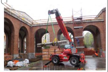
TUTTO IL TRAVE PORTANTE DEL PORTICATO DI SINISTRA, VUOI PER L'ASSESTAMENTO, VUOI PER LA SCARSITÀ DI FERRO UTILIZZATO IN TEMPO DI GUERRA PER LA COSTRUZIONE, COL TEMPO SI E' SPEZZATO IN TRE PUNTI
